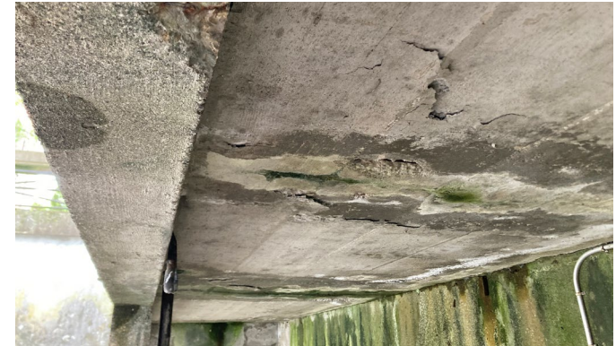
Betonvordach Hof Grütlistrasse
