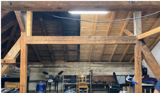
Fehlender Brandschutz Dachwerk
